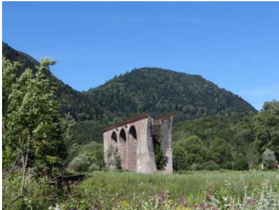
Viaduc à URBES (à proximité du terrain de camping aux alentours du Col de Bussang)
